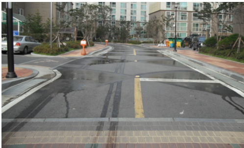
〈안산시 단지 내 클린로드 설치사례 3) 〉
