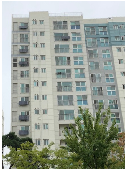
〈베란다 태양광 패널 설치 9) 〉
