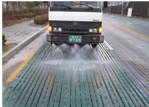
〈투수성 포장 시공 후〉
