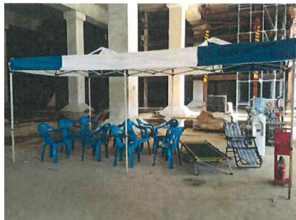
〈공사장 내 그늘막 설치 3) 〉
