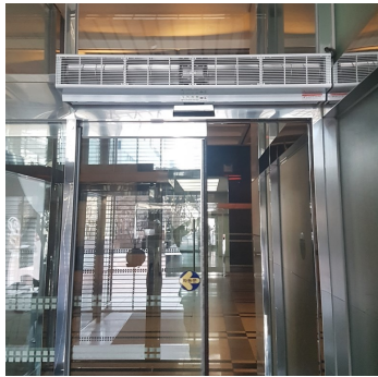
〈건물 출입구 에어커튼 설치 2) 〉
