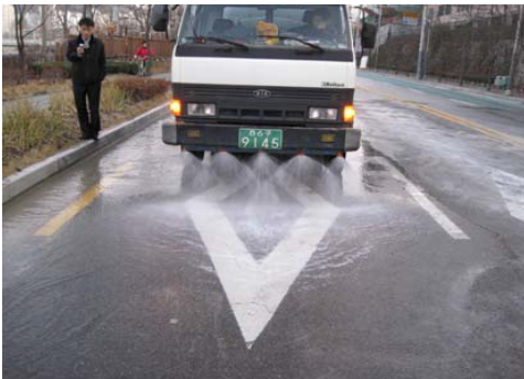
〈투수성 포장 시공 전〉
